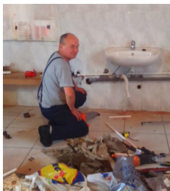
réparation des canalisations
